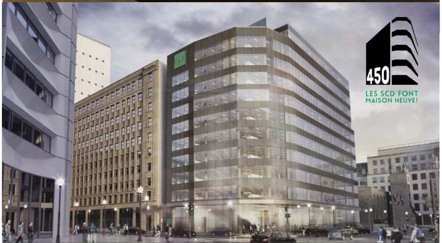
Nouvel immeuble du SCD au 450, boul. De Maisonneuve Ouest, Montréal (Québec)
